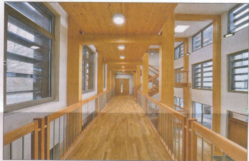
Die Treppen und Stege im Verbindungsbau sind massive Holzkonstruktionen.
