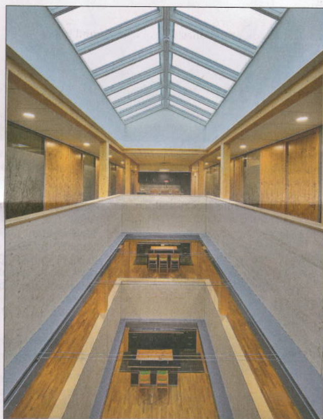
Der Lichthof mit offen sichtbaren, massiven Holzbauerelementen verbindet die drei Geschosse des neuen Verwaltungsgebäudes miteinander. Im Brandfall fahren die zwischen den Stockwerken eingelassenen Brandschutzdecken aus.
