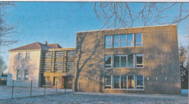
Das Gebäude-Ensemble der neuen NLF-Betriebsleitung in Braunschweig: Der Altbau, eine Villa aus den 1920er-Jahren, wird über Treppenhaus und Foyer verbunden mit einem neuen dreistöckigen Holzständerbau.
